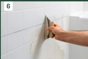
**[6]** Den Kleber abschnittsweise mit dem Zahnpachtel auftragen und zügig mit dem Verlegen der Platten links anfangend beginnen. Wichtig: Das Nutprofil muss nach unten ausgerichtet sein, damit die Feuchtigkeit ablaufen kann.
