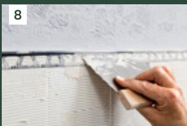
**[8]** Das Abschlussprofil sorgt für einen sauberen Abschluss, einfach in den Kleber einarbeiten.
