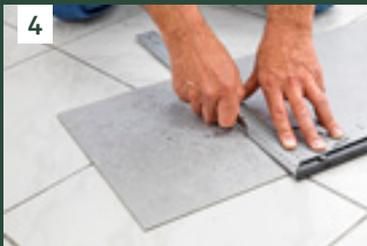
**[4]** Beginnen Sie die Verlegung mit der unteren Plattenreihe. Ggf. muss diese in Höhe und Breite etwas gekürzt werden. Der Zuschnitt erfolgt ganz einfach durch das Anritzen mit dem Cuttermesser und anschließendem Kantenbruch auf dem Knie.
