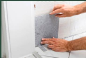
**[7]** Setzen Sie zuerst die Platte von oben an die untere und schieben Sie sie dann nach links in die vorherige. Wichtig: Achten Sie darauf, dass Nut & Feder vollständig ineinandergeschoben sind.
