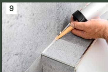
**[9]** Nach etwa 12 Std. Trocknungszeit können Sie die Anschlussfugen mit Silikon füllen und anschließend mit einem Keil glattziehen.
