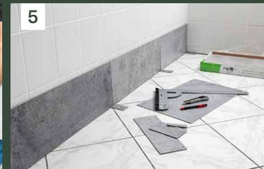
**[5]** ProfiTipp: Legen Sie die Platten probeweise einmal an der Wand aus, um Fehlmessungen auszuschließen.
